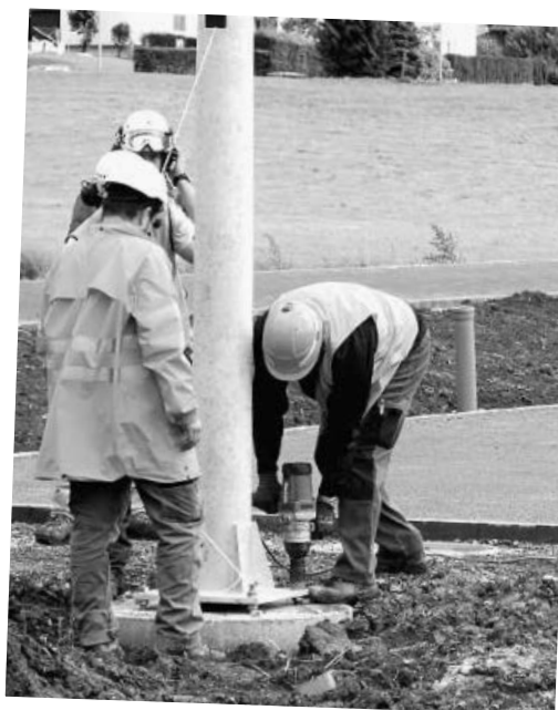
Montage an die Fundamente
