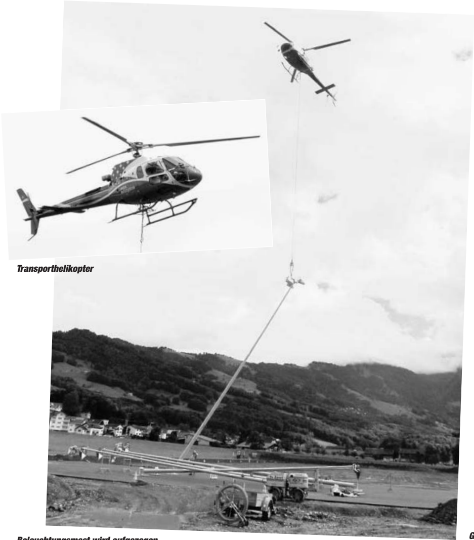
Beleuchtungsmast wird aufgezogen
